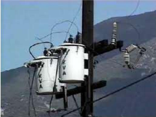
Se denomina **transformador** a un dispositivo eléctrico que permite aumentar o disminuir la tensión en un circuito eléctrico de corriente alterna, manteniendo la potencia. La potencia que ingresa al equipo, en el caso de un transformador ideal (esto es, sin pérdidas), es igual a la que se obtiene a la salida. Las máquinas reales presentan un pequeño porcentaje de pérdidas, dependiendo de su diseño y tamaño, entre otros factores.
