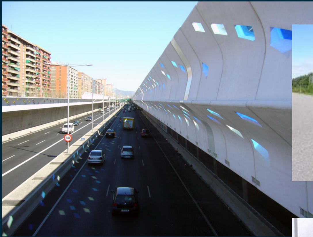
Carretera en trinchera y con pantallas acústicas
