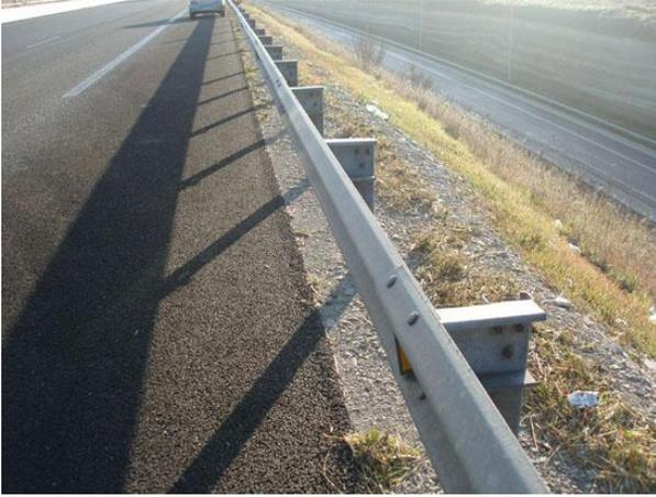
Cuando el objeto golpeado es muy rígido, como una barrera o un poste, toda la energía debe ser absorbida por el vehículo. Durante la colisión, la deformación continúa hasta que se ha absorbido toda la energía involucrada en el accidente, es decir, hasta que la energía cinética es igual a la energía necesaria para deformar la estructura
