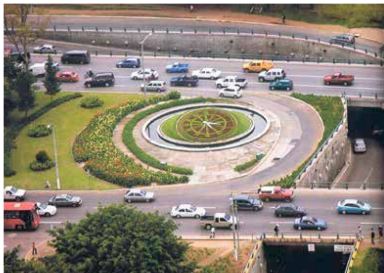
Paso a desnivel en el bulevar Liberación y 7a. av. Foto: Rodrigo Castillo
