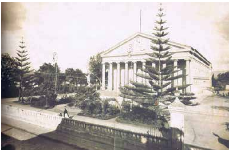
Teatro Colón. Al momento de su estreno en 1859, se llamó Teatro Carrera; en 1871 se le denominó Teatro Nacional; y en 1892 Teatro Colón, en homenaje al IV centenario del descubrimiento de América. Fue dañado durante los terremotos de 1917-1918; su reconstrucción se inició durante la dictadura de Manuel Estrada Cabrera y terminó cuando este fue derrocado en 1920. En 1924 José María Orellana lo mandó a demoler. (Colección Lanuza)
